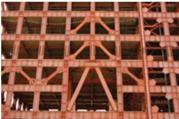
شکل ۱-۱- ساختمان با سازه اسکلت فولادی
